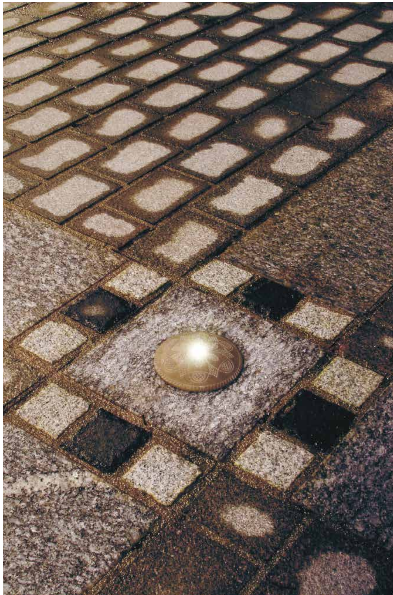
Projekt med markeringsknapp med lysdiod i brons.
