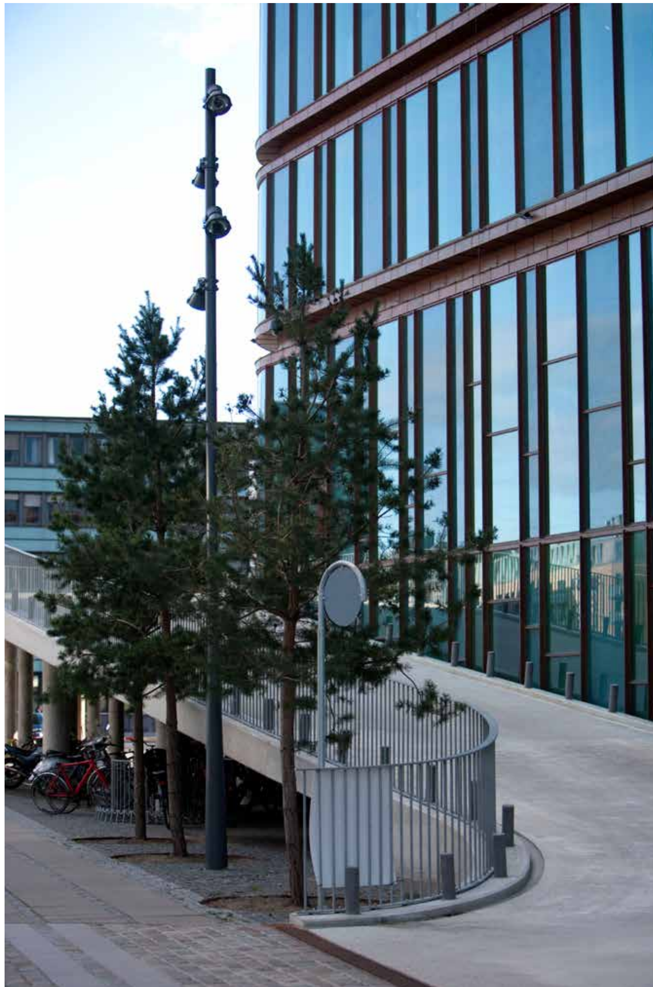
SEB-huset, Kalvebod Brygge. High-Light Belysningsmasten är ritad av SLA och är i aluminium och tillverkad i ett stycke utan sammansvetsningar.
