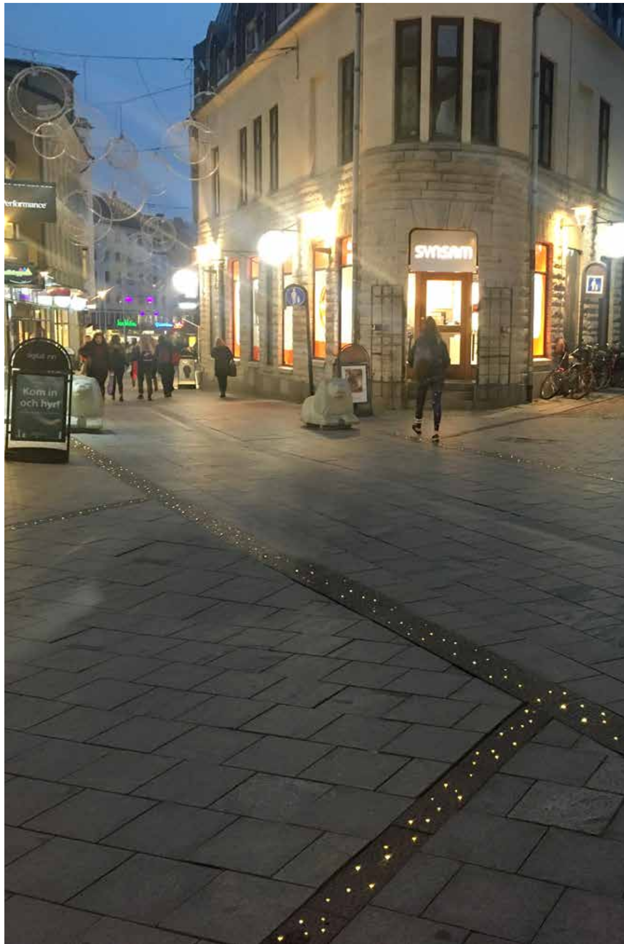
Linköpings gågata, Sverige. Campus Ljuslinje är en beläggning av gjutjärn med inbyggd belysning som används för att markera en särskild riktning eller platser i stadsmiljön.
