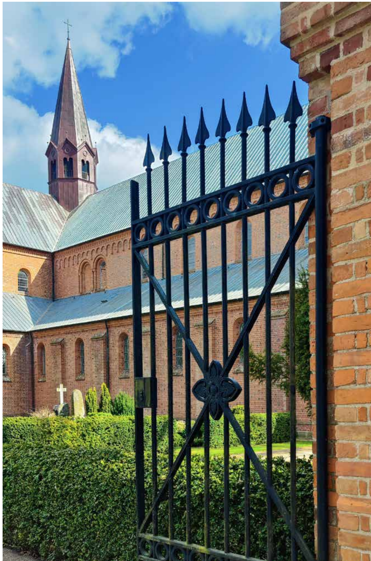
Porten till Sorø Klosterkirkes kyrkogård är gjuten i gjutjärn för över 15 år sedan. Den är gjuten i ett stycke utan skarvar – med många detaljer, däribland gaffeln till stödhjulet.
