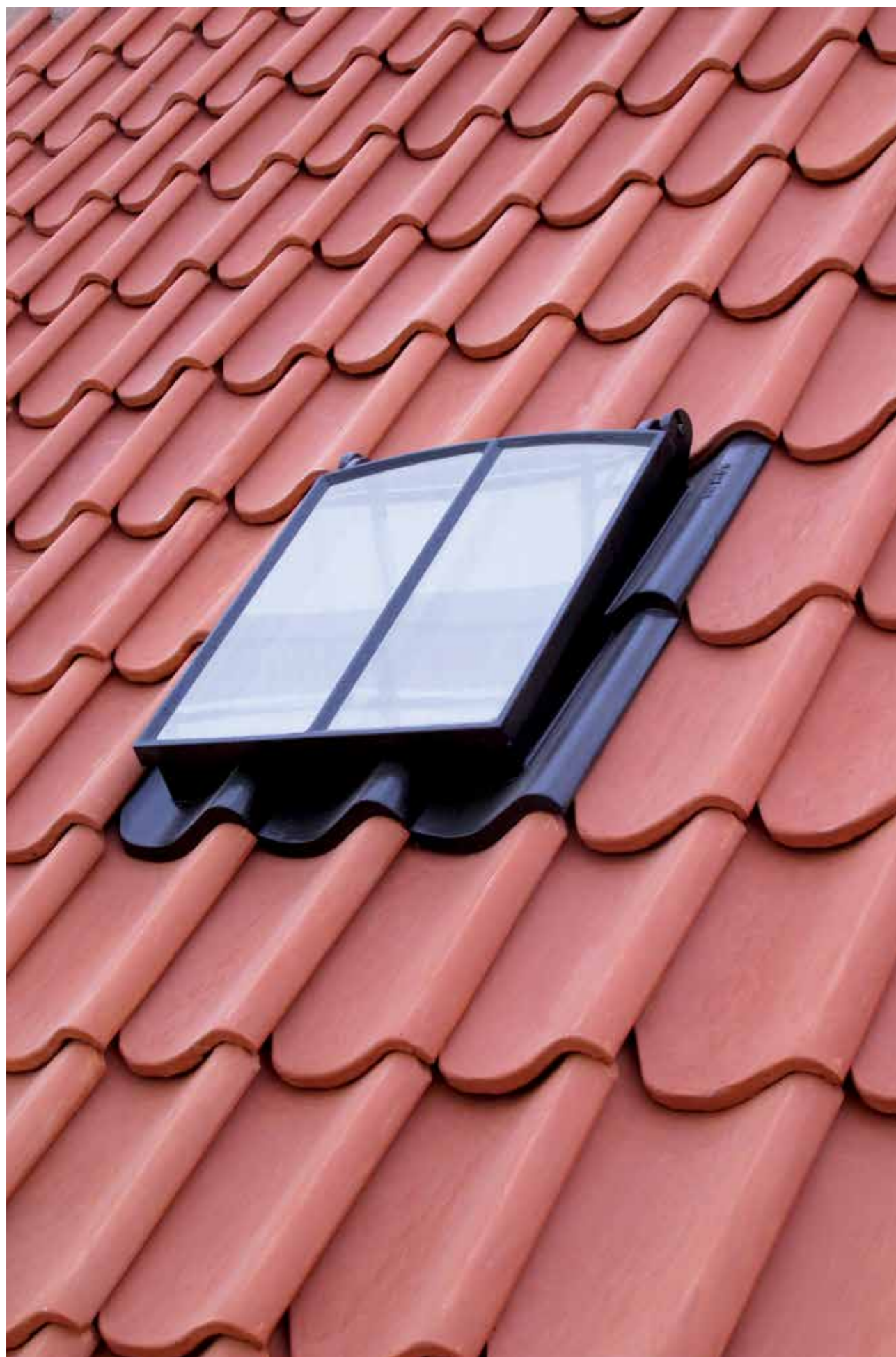
6-pannors takfönster i gjutjärn med en lodrät spröjs, Dantegl, JP2 handslagna enkupiga takpannor från Monier. Nylagt år 2020 i samband med pågående renovering av Nyboder, Köpenhamn.
