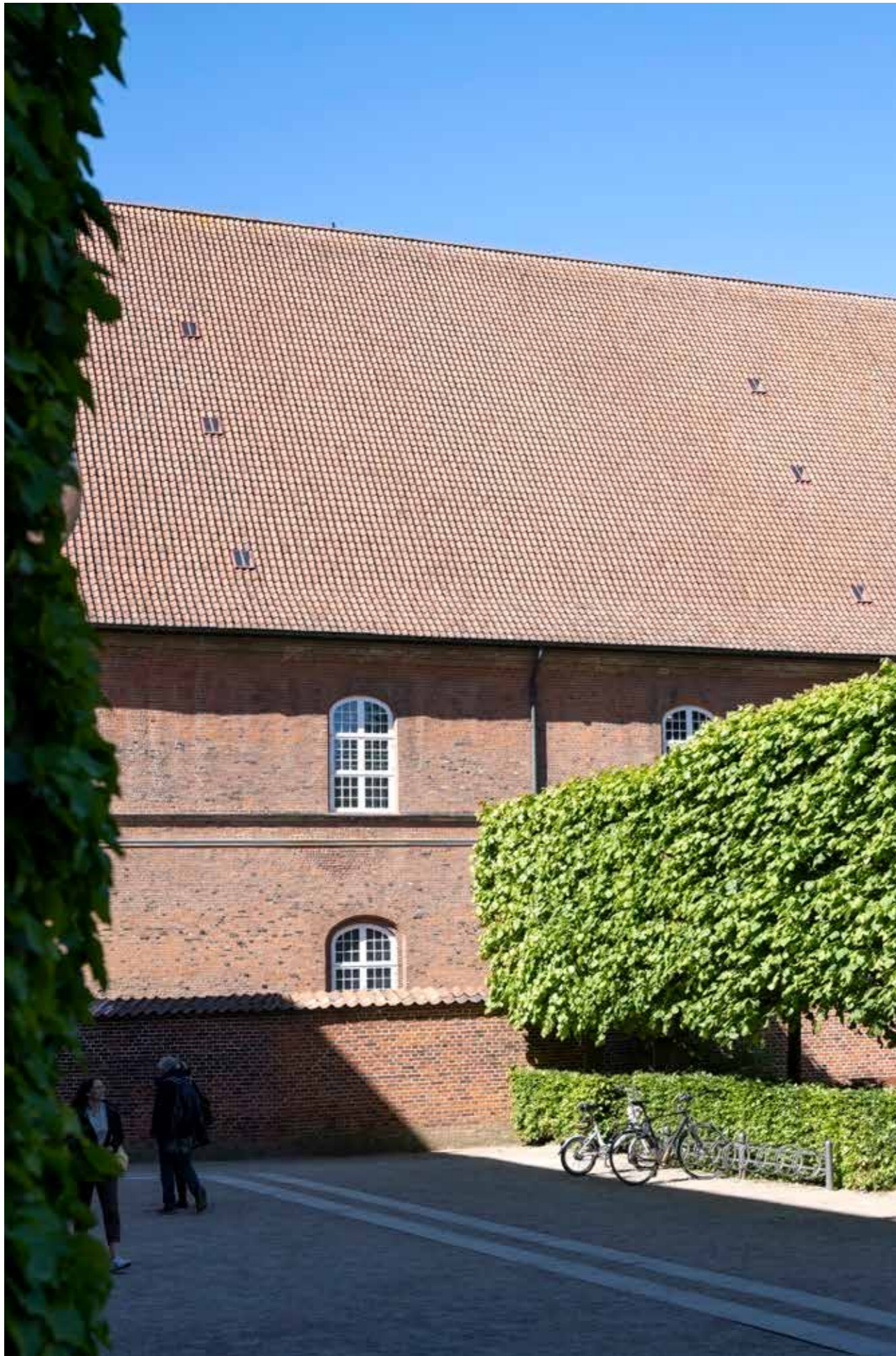
9-pannors oisolerade takfönster, Dantegl, handslagna enkupiga takpannor från Monier på Christian IV's Bryghus, Köpenhamn.
